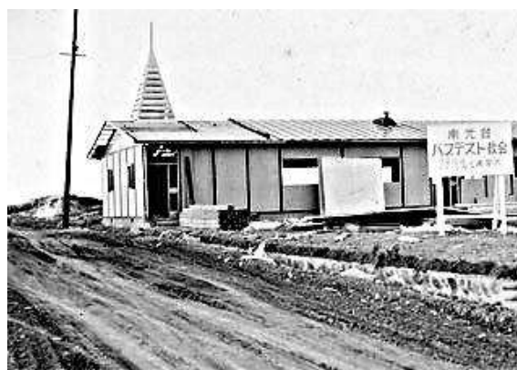
建設中の南光台伝道所会堂 1966
